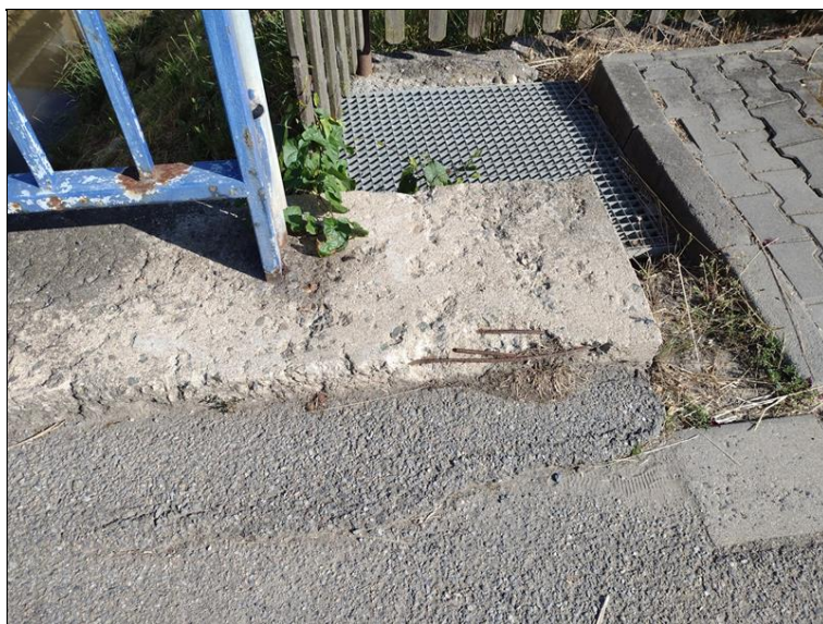
Odhalená korodující výztuž pravé římsy
