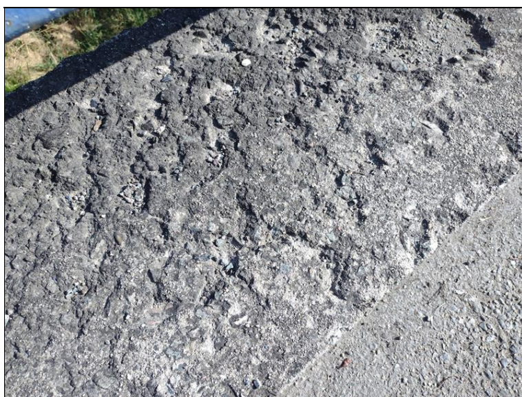
Degradace povrchu římsy
