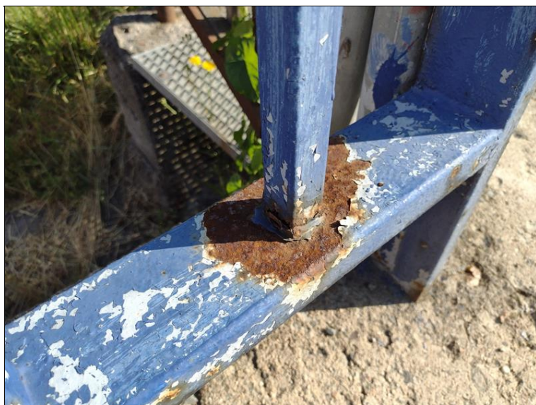
Koroze zábradlí
