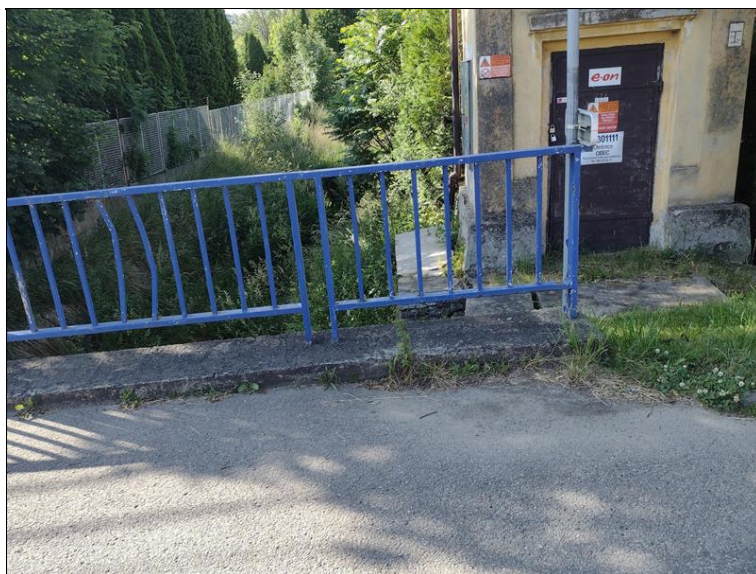
Deformace zábradlí na levé straně mostu
