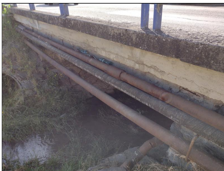
Koroze chrániček na pravé straně mostu
